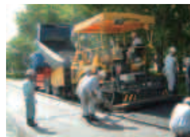
アスファルトラバー 試験施行風景
