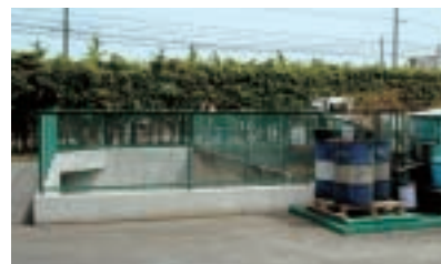
第2油水分離槽改修後
