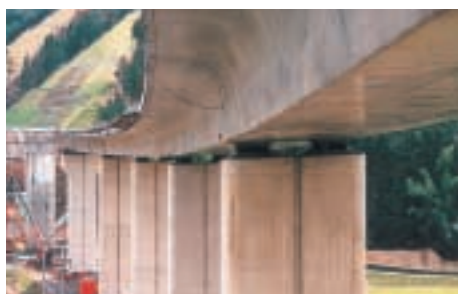
ゴム支承による橋梁の耐震補強
