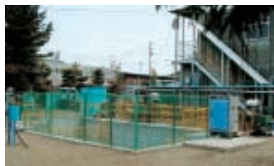
第1油水分離槽改修後
