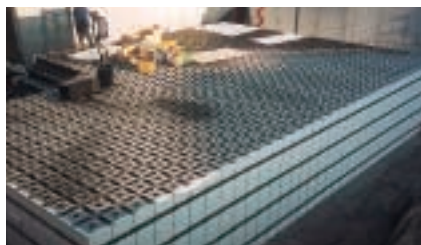
雨水貯留浸透システム(TUTT工法)の施工例
