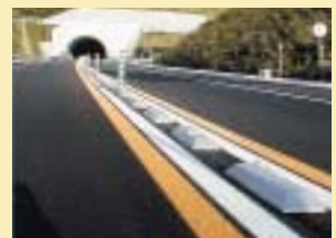
道路の中央分離帯「エコブロック」
