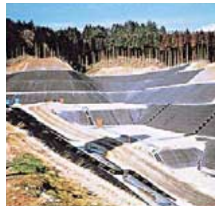
「遮水シート」の敷設工事
